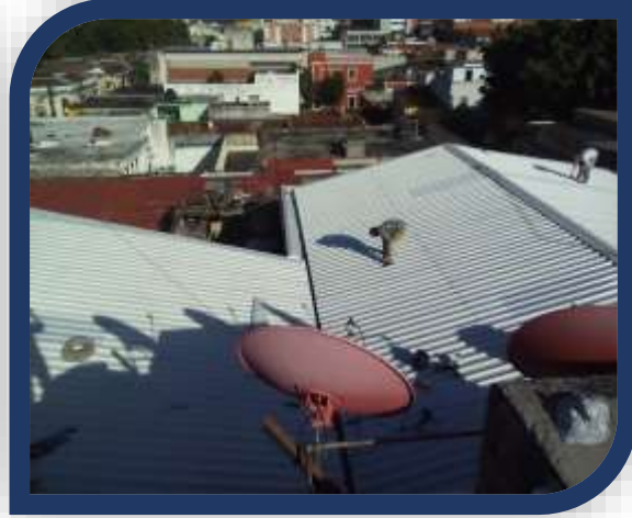
Cambio de láminas del techo del parqueo
