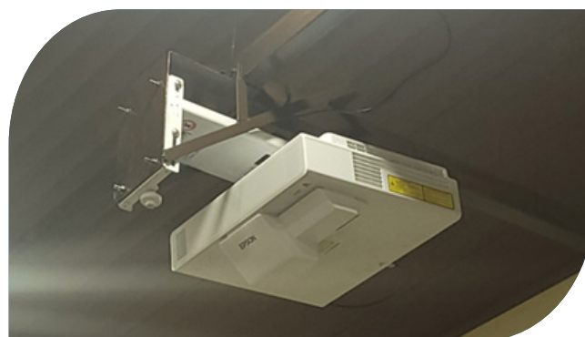
Instalación de nuevo proyector interactivo en salón.
